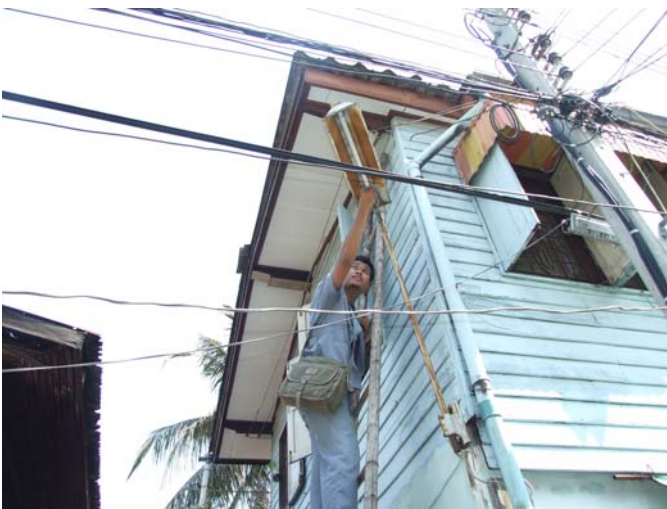
เปลี่ยนหลอดไฟส่องทางสาธารณะของชุมชน
