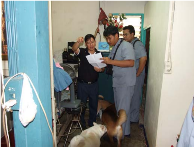
ชี้แจงในจุดที่เป็นอันตรายเพื่อทำการซ่อมแซม
