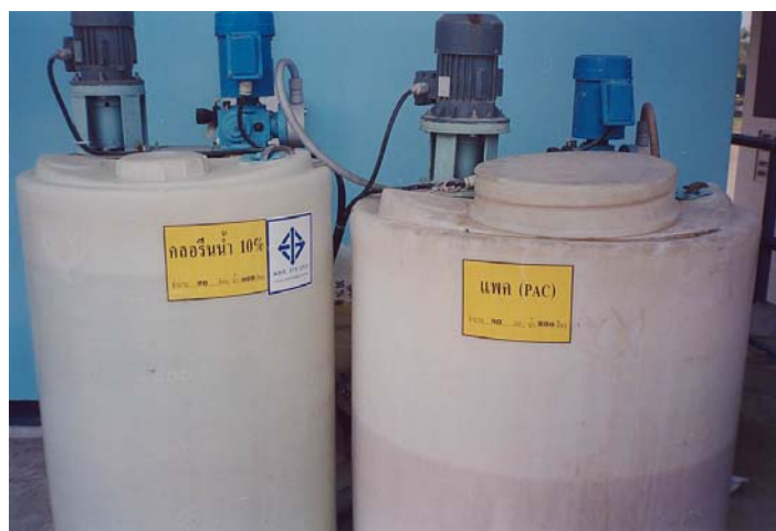
รูปที่ 6 ถังบรรจุสาร คลอรีนและแพค ที่ใช้ในการปรับสภาพน้ำดิบ
